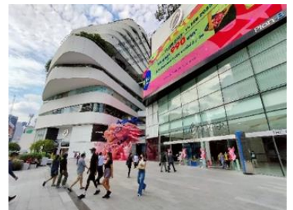
The EmQuartier 外観
