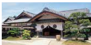
あいづ ぶけ やしき 会津武家屋敷 東山町院内 市街区 D-1
