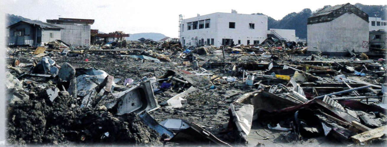
釜石市鵜住居地区防災センター(写真中央)
