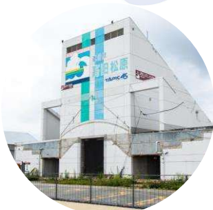
旧道の駅高田松原 タピック45
