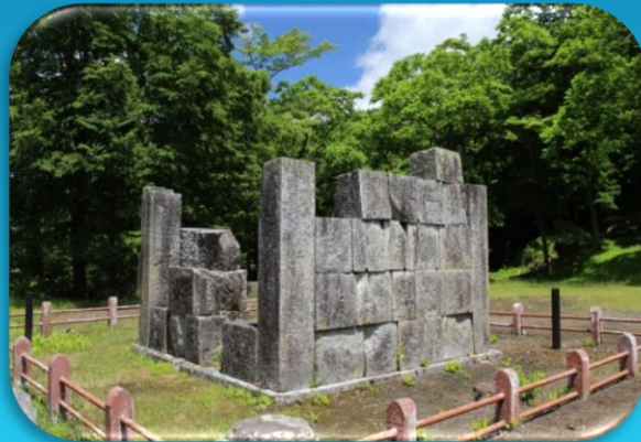
橋野鉄鉱山【釜石市】
